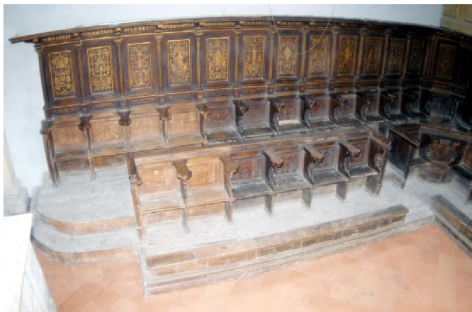
“prima dei lavori”
