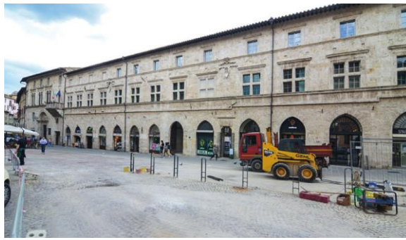
Piazza Matteotti durante i lavori
